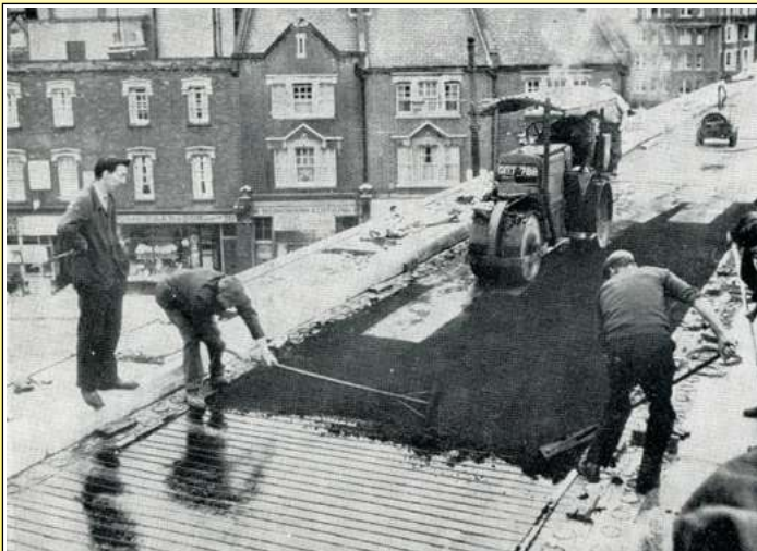
1969 Colocación de asfalto en la calzada superior de un cruce Hammerschmidt en Londres (Calefacción eléctrica de las carreteras, por Robert Félix, 1971, Museo Ultimheat*)
