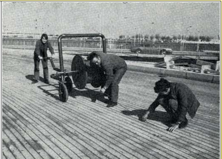
1968 Instalación de la malla calefactora en una rampa de acceso a una plataforma de estacionamiento de autobuses, aeropuerto de Orly cerca de París (Calefacción eléctrica del suelo, por Robert Félix, 1971, Museo Ultimheat*)
